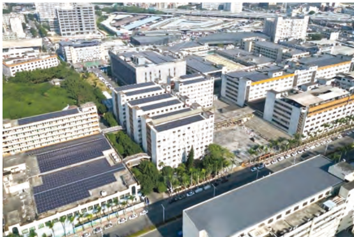
Solar Energy Project on Factory 廠房太陽能項目
